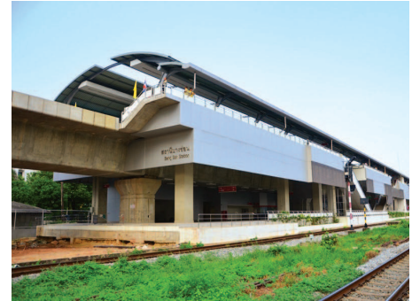
สถานีบางซื่อ
