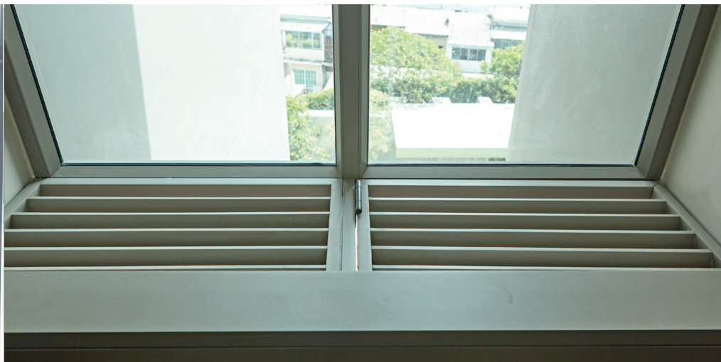
ช่องเกล็ดอลูมิเนียม เจาะอากาศผ่านเข้า-ออก โดยสามารถกันน้ำฝนได้เป็นอย่างดี
