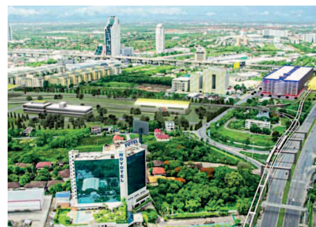
สถานีศรีเอี่ยม อาคารซ่อมบำรุงและอาคารจอดและจร
